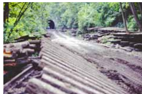
Vor dem Ostportal stapelten sich die Gleisjoche aus dem Tunnel auf einer Länge von 100 Metern.
