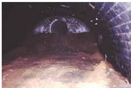
Die nur lose aufgeschüttete Erde vor der Röhre am Ostportal.
