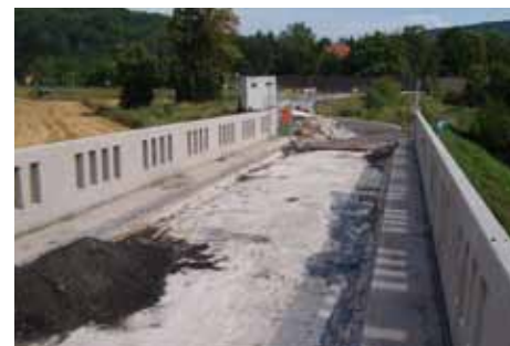
Die Werrabrücke während der Sanierung.
