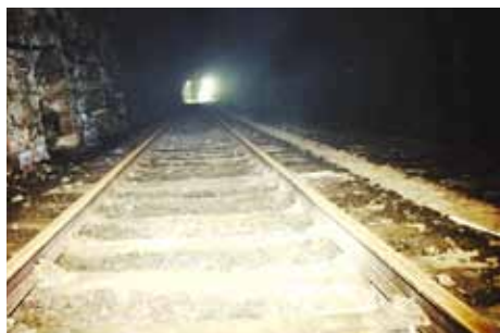
Blick in den Tunnel. Die beiden Gleise sind hier noch gut zu erkennen.
