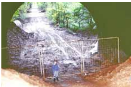
Blick aus dem Ostportal während der seitlichen Erdaufschüttung.
