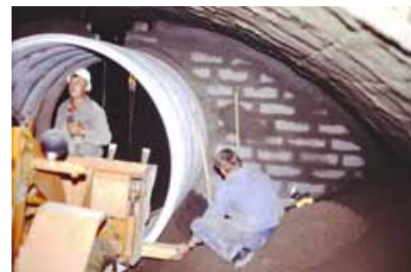
Im Tunnelinneren wurde am Ende der Röhre die angefüllte Erde geebnet.
