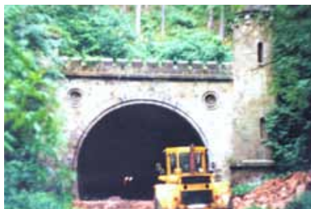
Das Ostportal des Tunnels nachdem die Mauer am Eingang abgerissen wurde.
