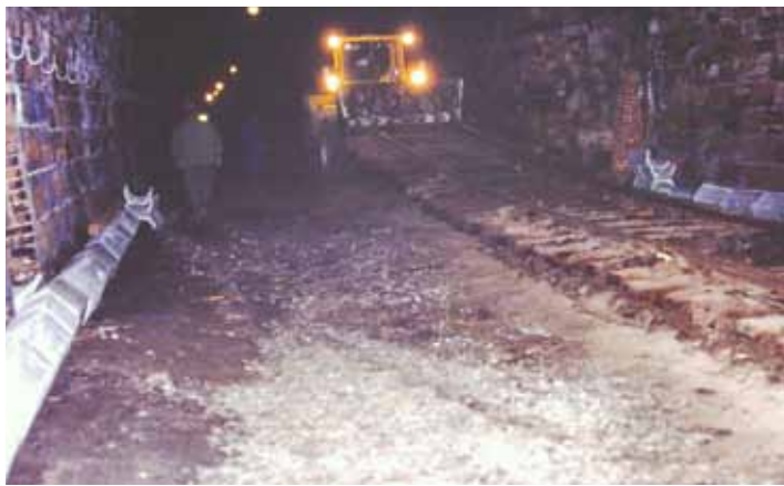
Im Bereich der Verfüllung wurden Rohre für das Tunnelwasser verlegt.
