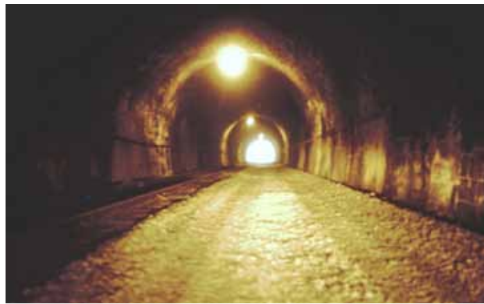
Nachdem die Gleise entfernt wurden, konnte der Boden geebnet werden.
