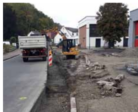
Arbeiten an der Zufahrt zum Feuerwehrhaus.
