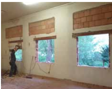
Neue Fenster im alten Gerätehaus.
