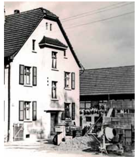
Bau der Poststelle in den 50er-Jahren.
