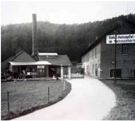
Werkseingang zwischen 1930 und 1940.
