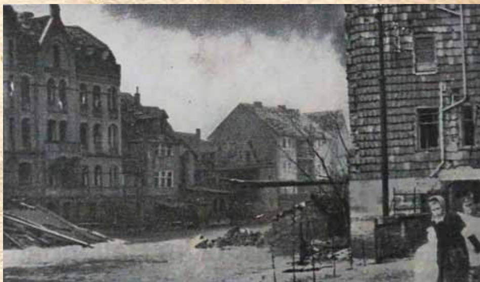
Eine der beiden gesprengten Werrabrücken in Eschwege.
