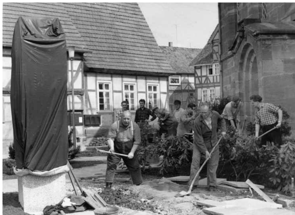
1959 wurde der Kirchen-Vorplatzes mit Hilfe der Friedaer Bevölkerung umgestaltet. Unter anderem waren Willy Flügel, Ernst Hering und Gerhard Heine beteiligt. Foto: Heimatverein Frieda
