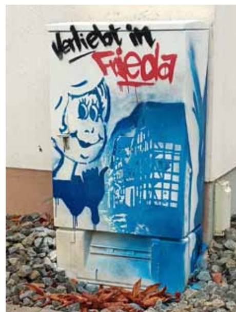
Noch nicht ganz fertiggestellt ist der Kasten zwischen Weinberghalle und Feuerwehrhaus.
