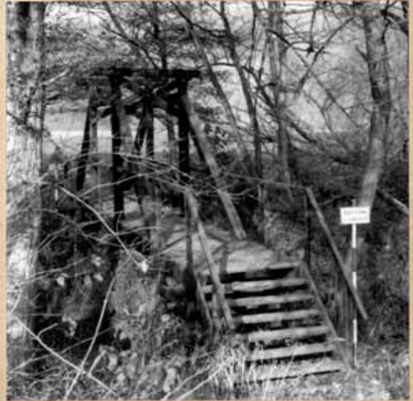
In der 1970er Jahren hatte der Bundesgrenzschutz diesen Steg über die Frieda in der Nähe der ehemaligen Grenze errichtet, um die Patrouillengänge zu erleichtern.
