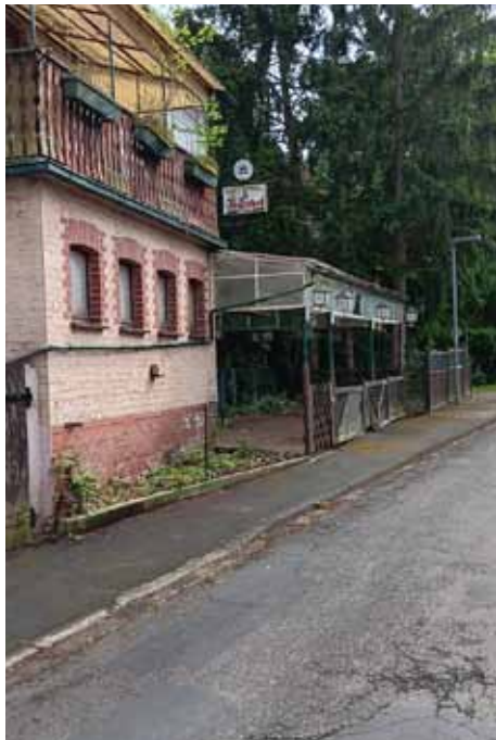
Die Straße und der Gehweg vor der ehemaligen Bahnhofsgaststätte wurde gereinigt.
