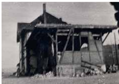
Durch ein Versehen wurde am 3. April 1945 der Bahnhof in Frieda beschossen und der Güterschuppen stark beschädigt.
