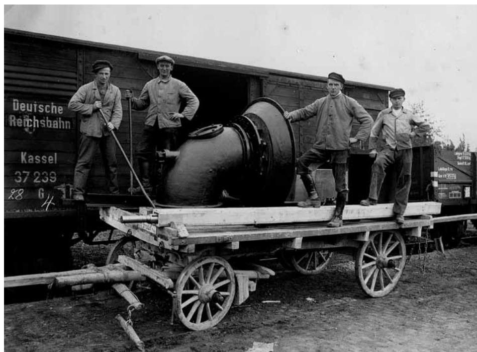
Das Foto aus dem Sommer 1934 zeigt die Anlieferung eines mächtigen Turbinenteils am Bahnhof in Frieda, das für die Stromerzeugung genutzt wurde.
