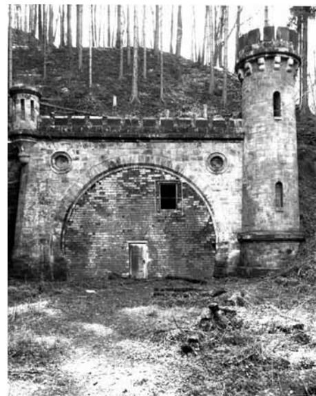
Das Portal des Frieda-Tunnels wurde Dank der Gemeinde Meinhard nicht abgerissen.
