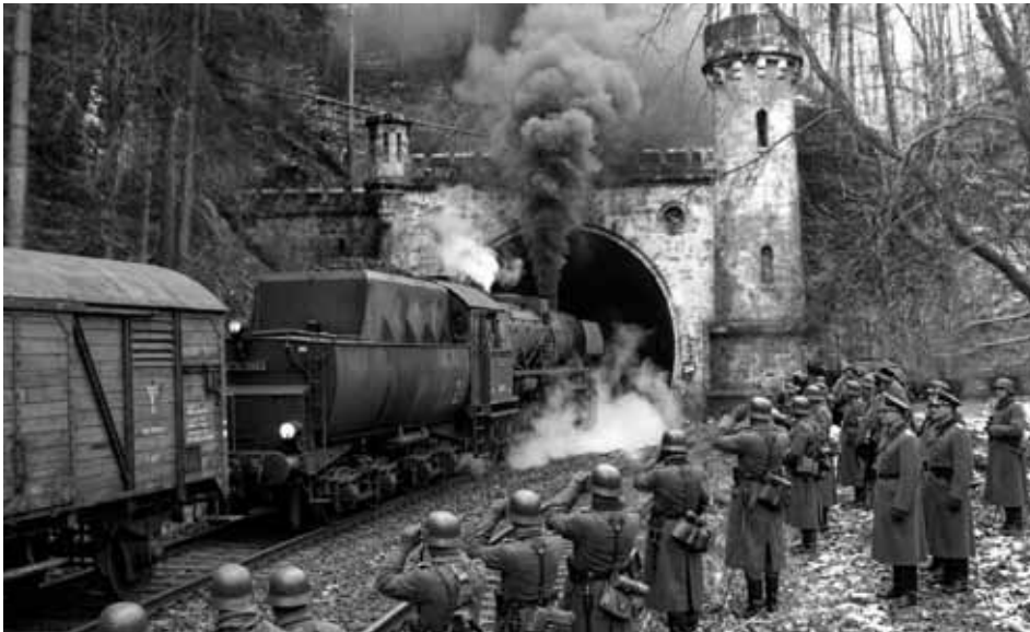
Die Einfahrt des Sonderzuges in den Frieda-Tunnel.
