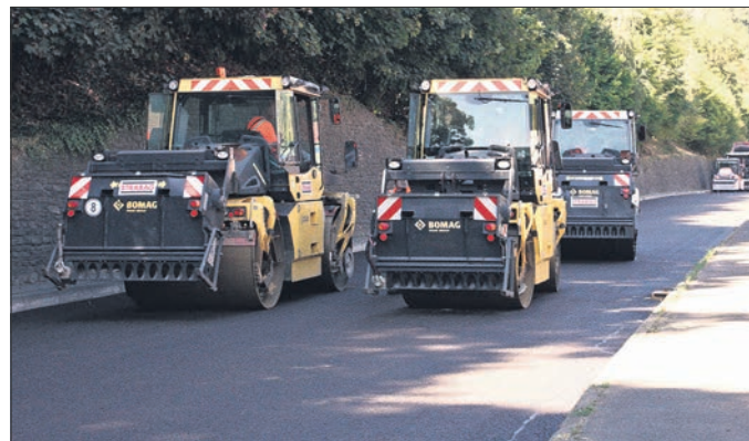
In einer konzertierten Aktion wird die Fahrbahn über die gesamte Breite verdichtet. Fotos: Beate Schuchard-Palmert
