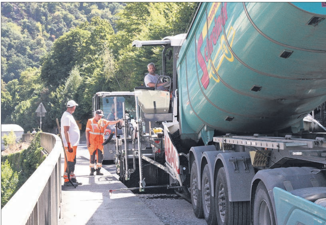
Bei langsamer Fahrt füllt der Lkw heißen Asphalt in den Asphaltfertiger. Der verteilt die Masse gleichmäßig auf dem Unterbau der Straße. Gleich danach verdichten Walzen diese Tragschicht.
