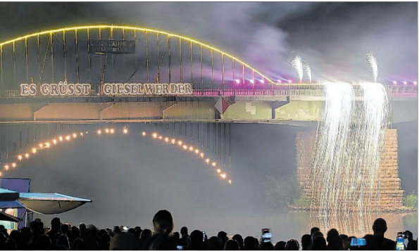
Eine beleuchtete Weserbrücke und ein Funkenwasserfall sind Blickfänge der Weserbeleuchtung in Gieselwerder.
