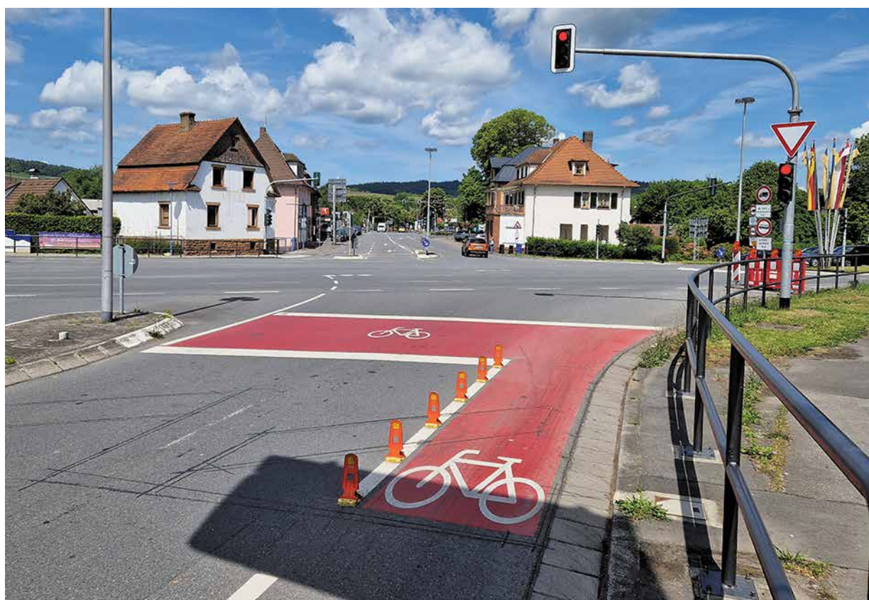
Ein sogenannter ARAS (aufgeweiteter Radaufstellstreifen) hilft in Michelstadt bei der Querung der Bundesstraße.
