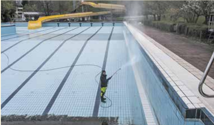
Beseitigung der Reste des Winters im Sprungbereich des Schwimmbeckens.
