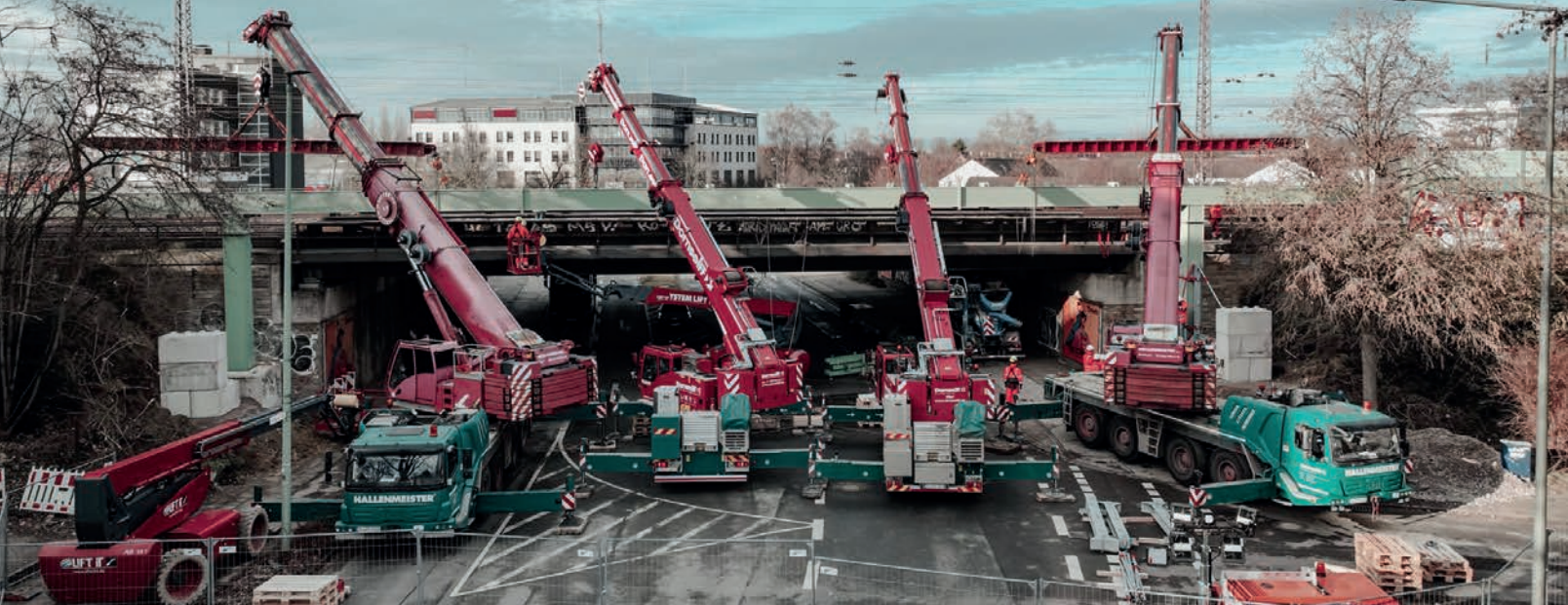
Ende März in In Duisburg waren gleich vier Dornseiff-Spezialkrane gleichzeitig im Einsatz: Ein Torsionsbalken wurde präzise im Verbund gesetzt.
