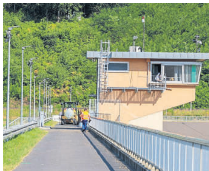
Die Vorbereitungen für die Demontage des Geländers sind in vollem Gange.
