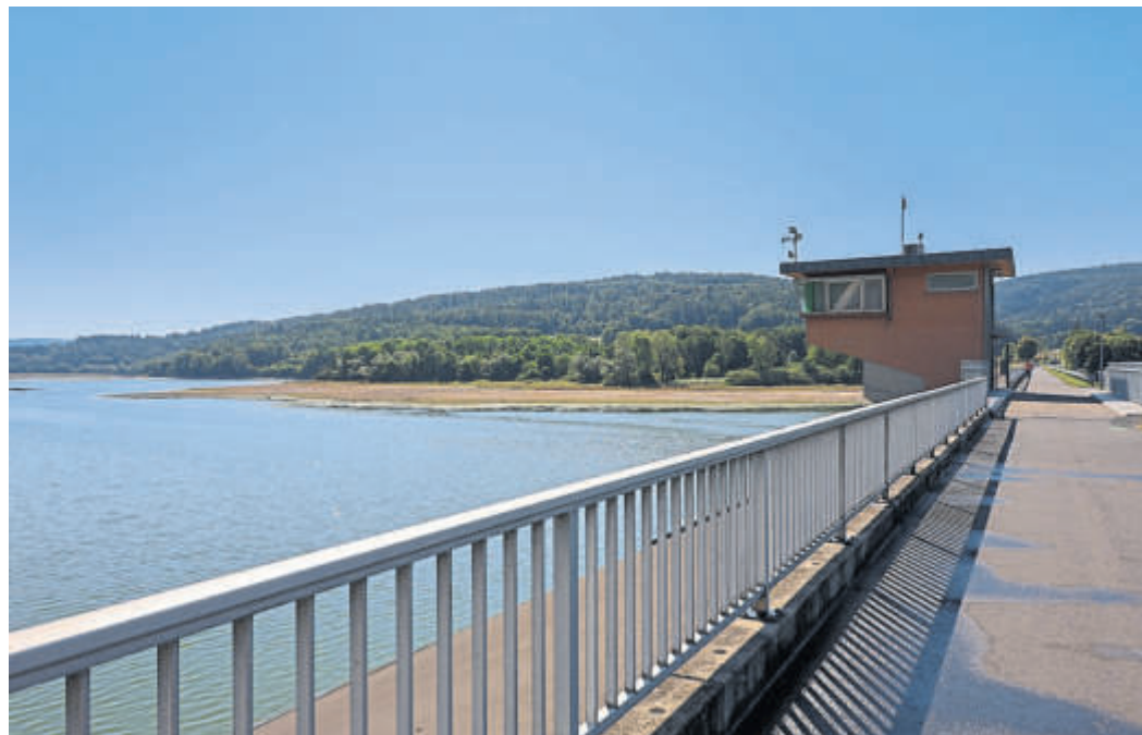
Für die Sanierung wird der Wasserstand planmäßig um rund 3,50 Meter abgesenkt.
