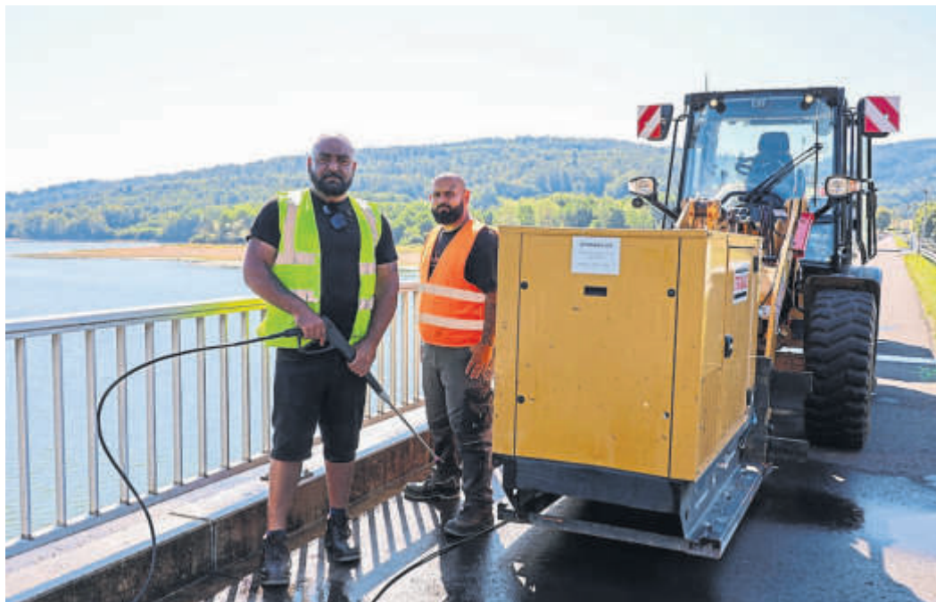
Mitarbeiter der Firma Strassing reinigen die Dammkrone mit einem Hochdruckreiniger.
