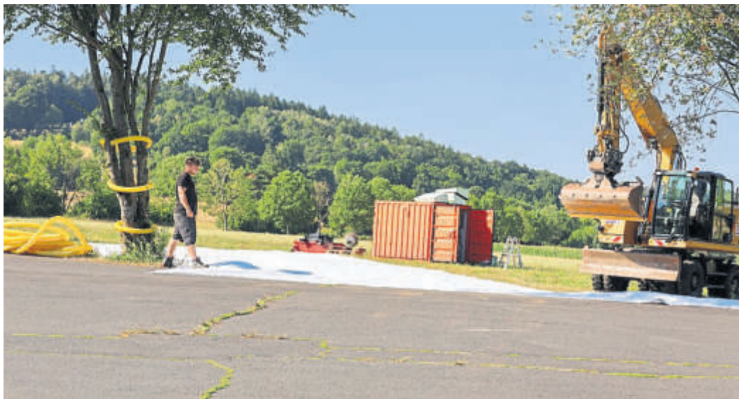
Zum Schutz der Bäume wurden vor Beginn der Arbeiten an der Kinzigtalsperre Schutzpolster an den Stämmen angebracht.
