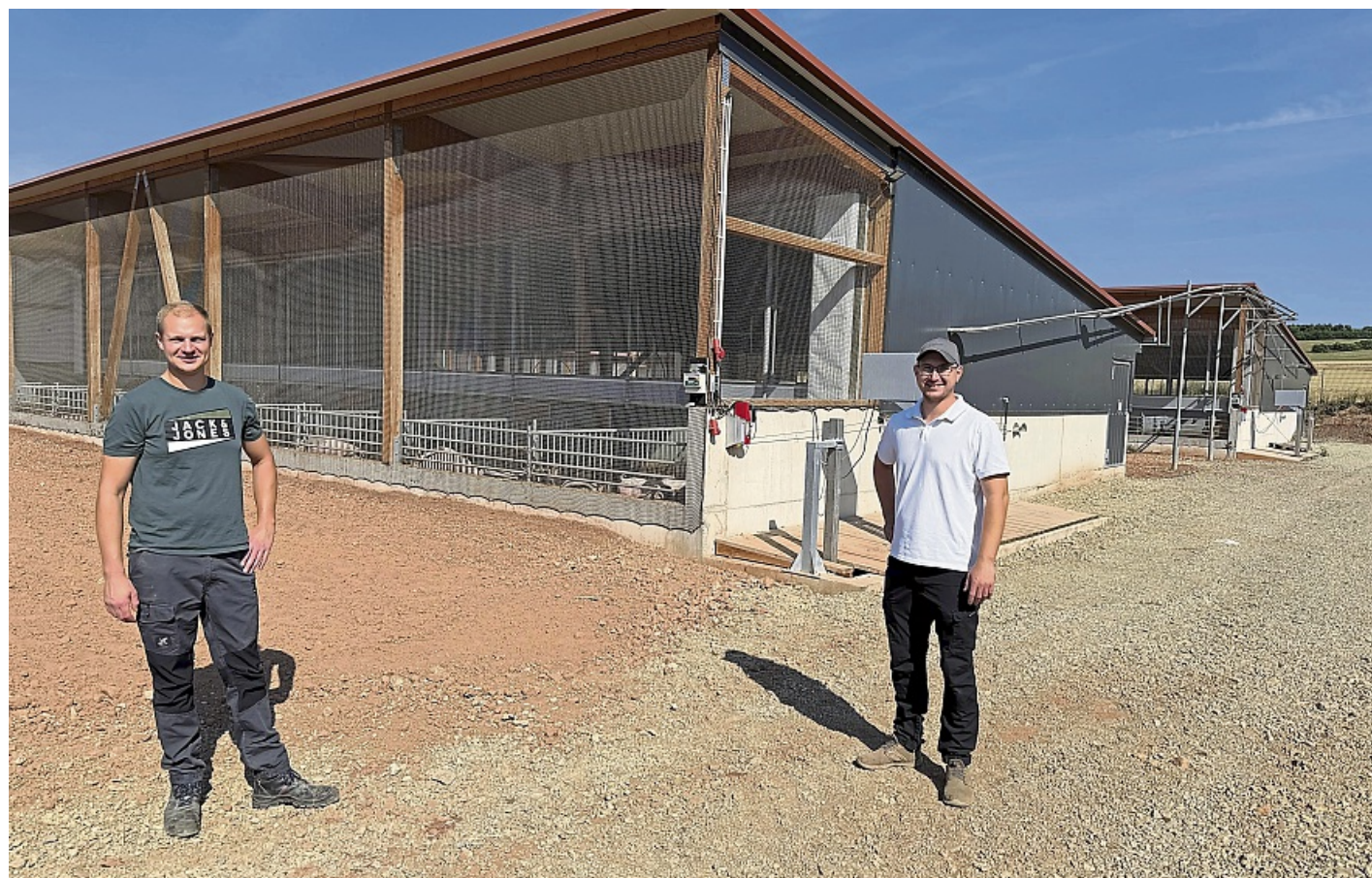
Johannes (27) und Julian Vering (30) präsentieren einen von zwei neuen Außenklimaställen mit Auslauf, die sie am Ortsrand von Dehausen für jeweils 690 Mastschweine neu gebaut haben. Das Fleisch der Tiere aus diesen geräumigen Ställen erfüllt die Anforderungen der Haltungsform 3.
