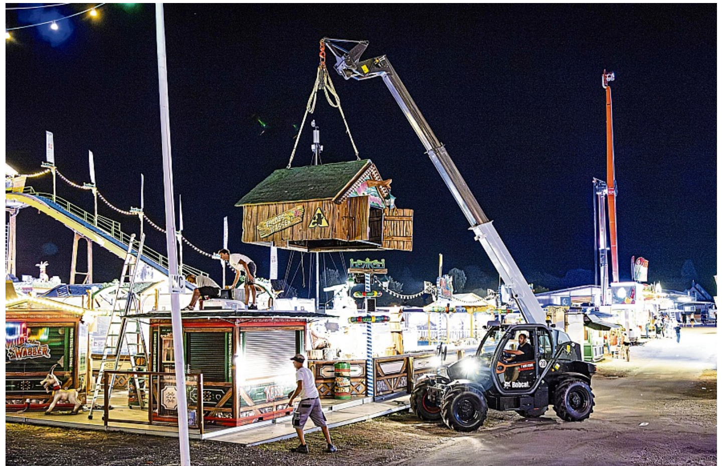
Ein Kran hebt das Kassenhäuschen der Wildwasserbahn an. Stück für Stück bauen die Schausteller das größte Fahrgeschäft für den Abtransport vom Festplatz ab. FOTO: MARVIN FISCHER
