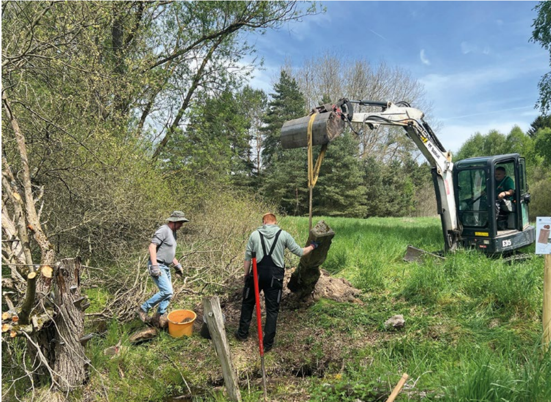
Abb. 4: Stein wird gesetzt (Foto: DVW Thüringen e.V.)
