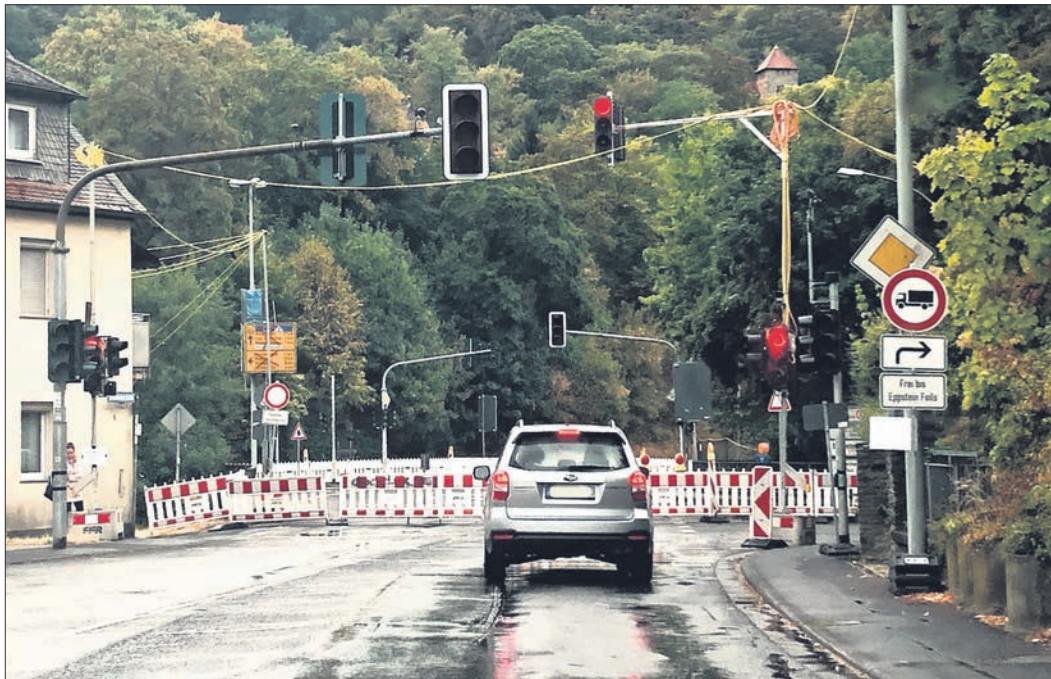
Trübe Aussicht – übers Wochenende bis Mitte dieser Woche blieb die Kreuzung B455/Lorsbacher/Fischbacher Straße gesperrt, weil Hessen Mobil die Ampelregelung für den nächsten Baubauabschnitt aus Sicherheitsgründen nicht verantworten wollte.
