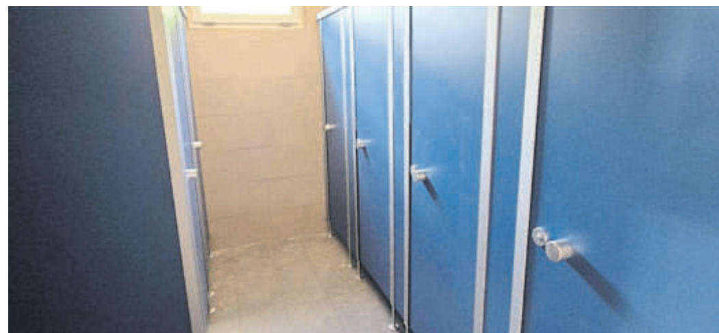
Die Sanitärbereiche sind schon fertig gestellt.
