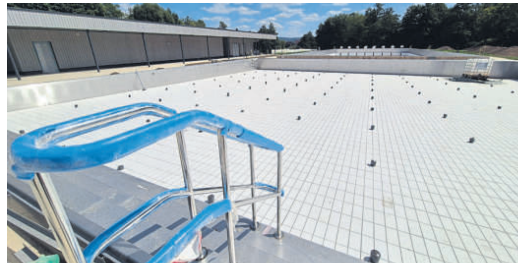
Für das Nichtschwimmer-Becken ist das künftige der Zugang.
