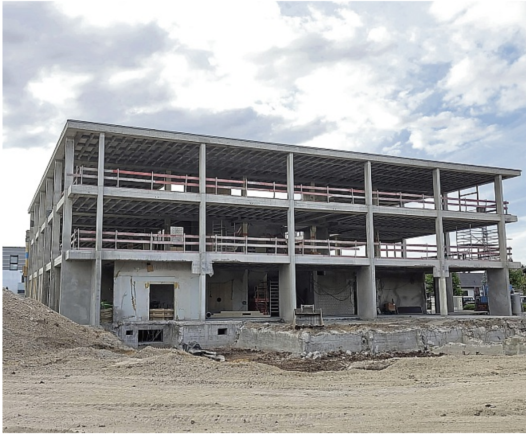
Das Erlenseer Rathaus ist in der Sanierungsphase: Sandstrahlarbeiten am Betongerippe sind für Lärmspitzen verantwortlich, die den Nachbarn zu schaffen machen. SABINE MÜLLER
