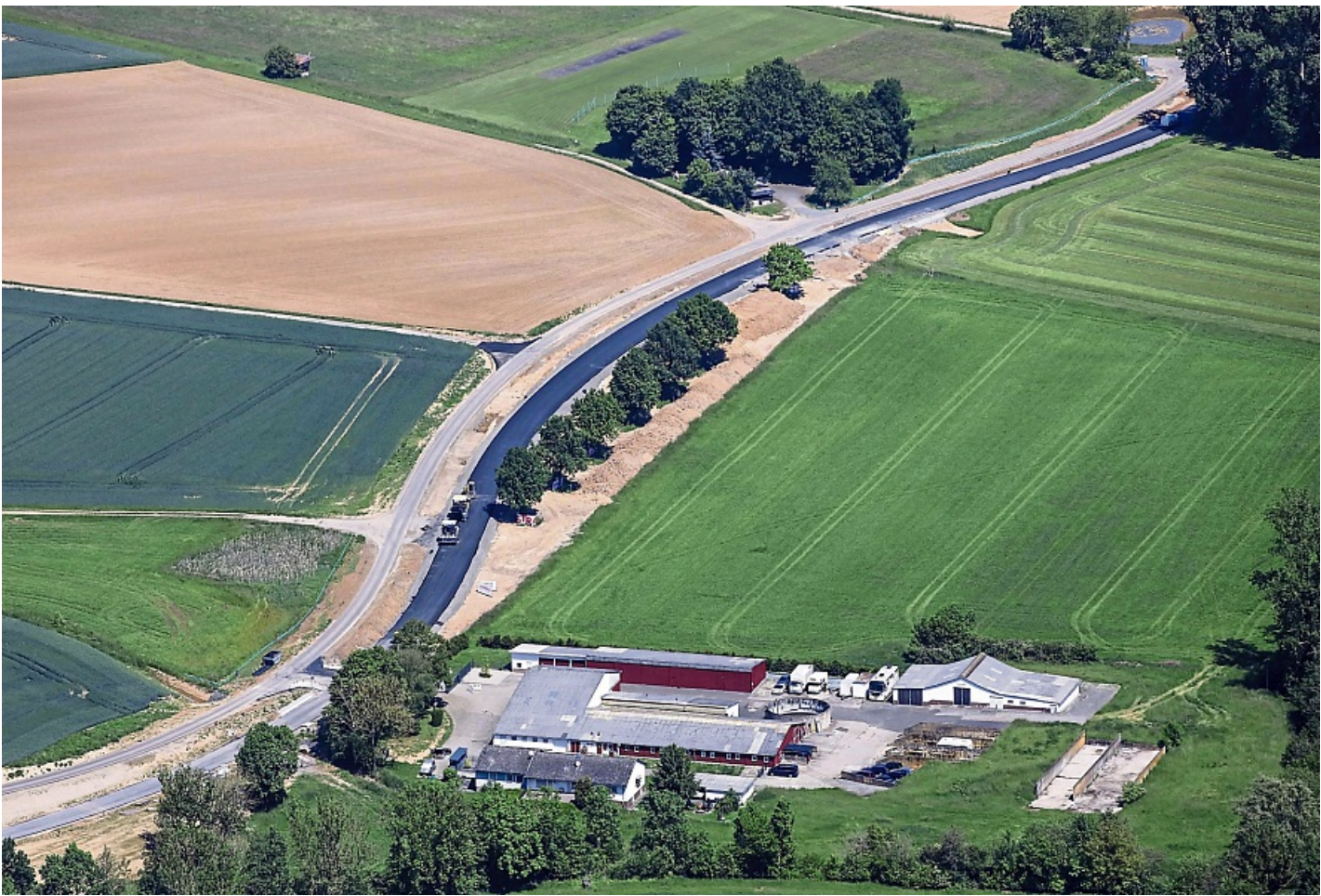
Aktuell wird der dritte und letzte Bauabschnitt der Landesstraße 3193 in Höhe des Eckenbachhofs umfangreich saniert.
