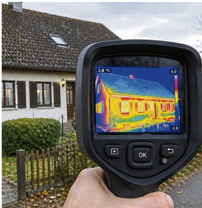
Mit einer Wärmebildkamera lässt sich erkennen, ob es am Gebäude Wärmebrücken gibt.
