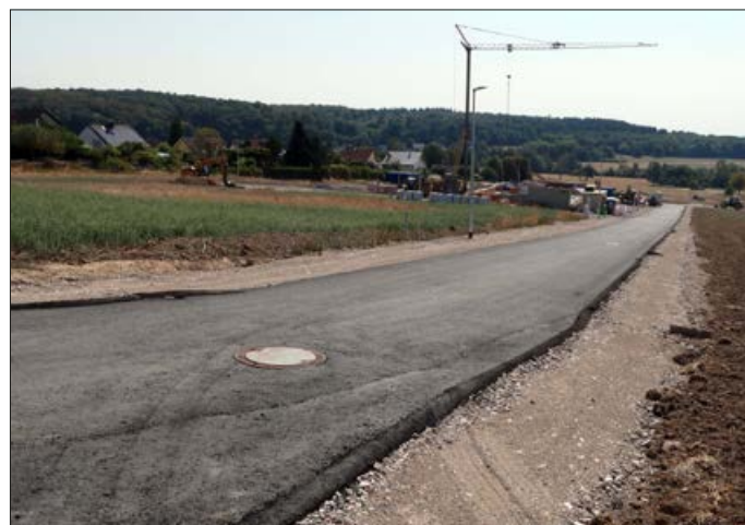
Das Neubaugebiet wird mit seinen beiden Straßennamen Bezug auf die benachbarte Bergbauhistorie nehmen. (Foto: Mattern)
