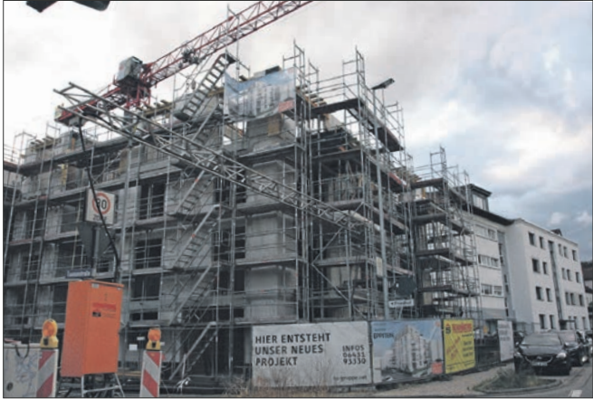
Noch überragt der Kran das neue Gebäude. Foto: bpa
