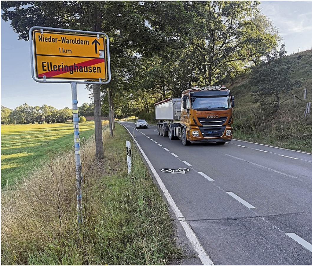
Die neuen Fahrradschutzstreifen auf der Landesstraße L3118 zwischen Elleringhausen und Nieder-Waroldern zeigen den Autofahrern, dass Fahrradfahrer Vorrang haben.
