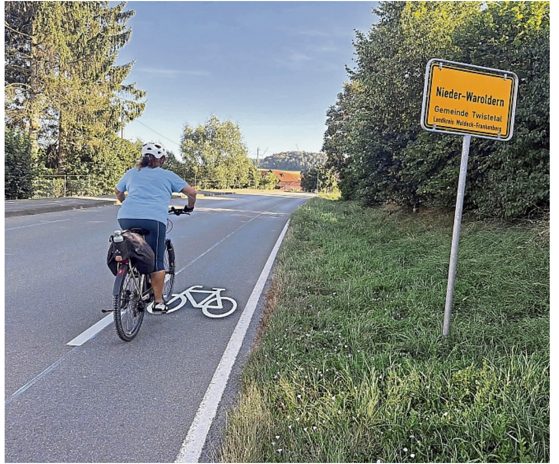
Außerorts sollen die neuen Fahrradschutzstreifen auf der Landesstraße L3118 zwischen Elleringhausen und Nieder-Waroldern Fahrradfahrer schützen. FOTOS: ELMAR SCHULTEN
