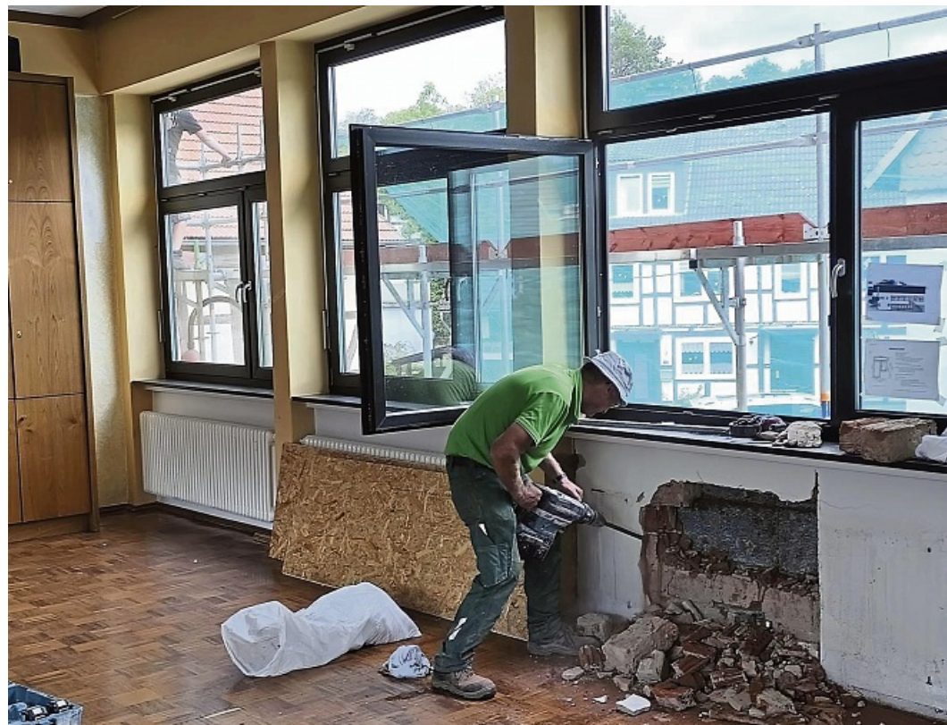
Durchbruch: Ein Handwerker stemmt im Saal des Adorfer Dorfgemeinschaftshauses die Außenwand auf. Dort soll ein zweiter Fluchtweg geschaffen werden.
