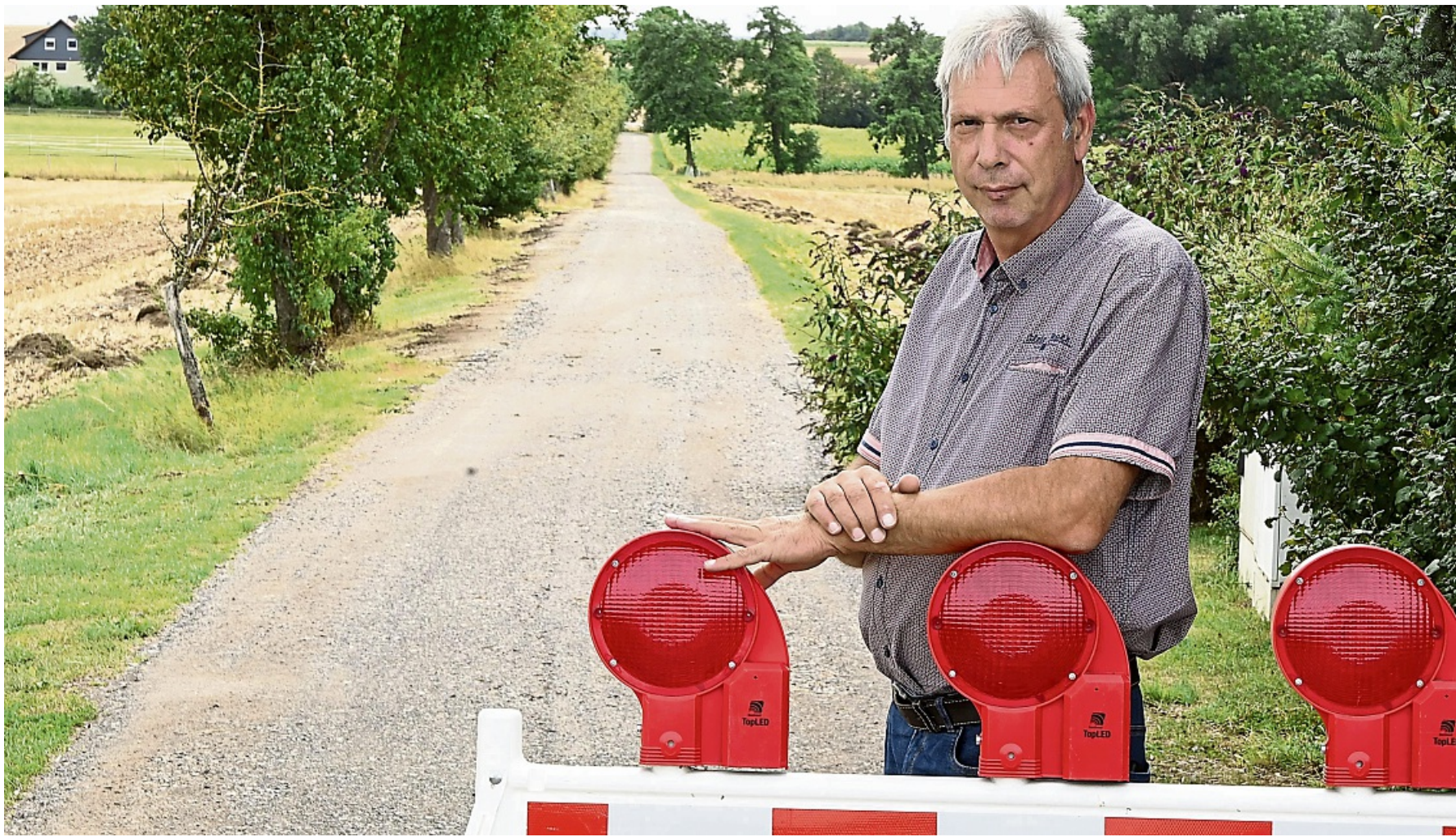
Zufrieden mit den neuen Wegen: Erik Rasner vom Stadtbauamt mit Blick in Richtung Ellerbruch vor Korbach. Der Feldweg präsentiert sich seit wenigen Wochen runderneuert und soll nun auf Jahre halten.
