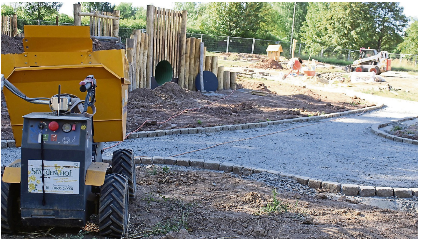
Bauarbeiten: Nahe des Waldkappeler Freibades nimmt der geplante Abenteuerspielplatz nach und nach Gestalt an.
