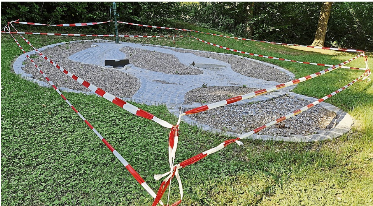
Wenig Spielwert: Der Wasserspielplatz im Immenhäuser Schwimmbad ist wegen Mängeln gesperrt. Nach der Saison soll er nachgebessert werden.
