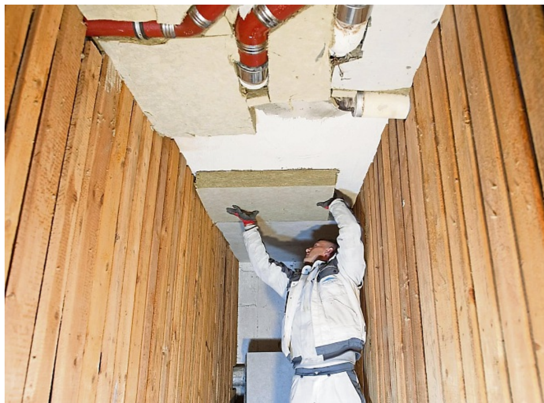
Kellerdecke dämmen, Heizkosten senken: Wer handwerkliches Geschick besitzt, kann die Dämmung der Kellerdecke selbst anbringen.
