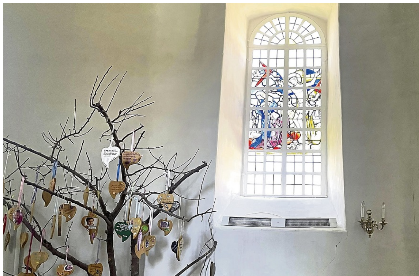
Zwei beschädigte Fenster wurden aufgearbeitet: Die Farben der Kirchenfenster sind nun wieder leuchtend.
