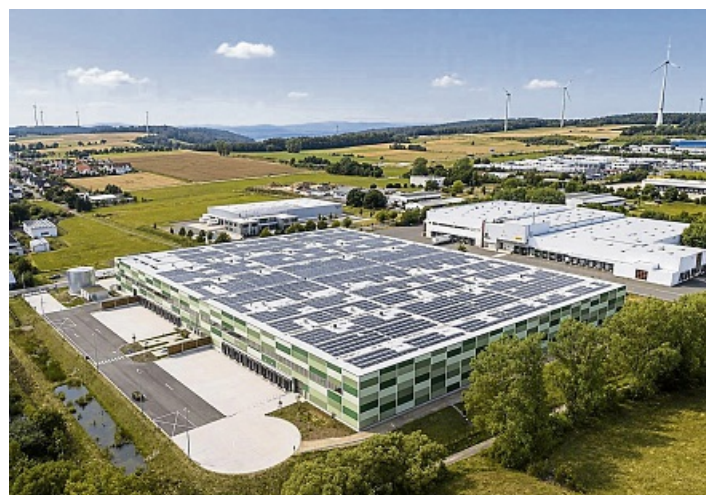
Aus der Vogelperspektive: In die Gewerbehalle Panattoni-Park im Gewerbegebiet Friedewald zieht der Logistikdienstleister 4PLCS mit einem Ersatzteillager für den Schienenfahrzeughersteller Alstom ein.
