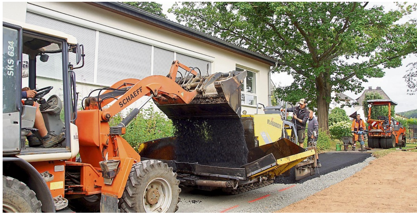
Neuer Asphalt: Auf dem Gelände der Beruflichen Schulen in Heimbildshausen sind die Mitarbeiter der Bad Hersfelder Bau-firma Räuber im Einsatz.
