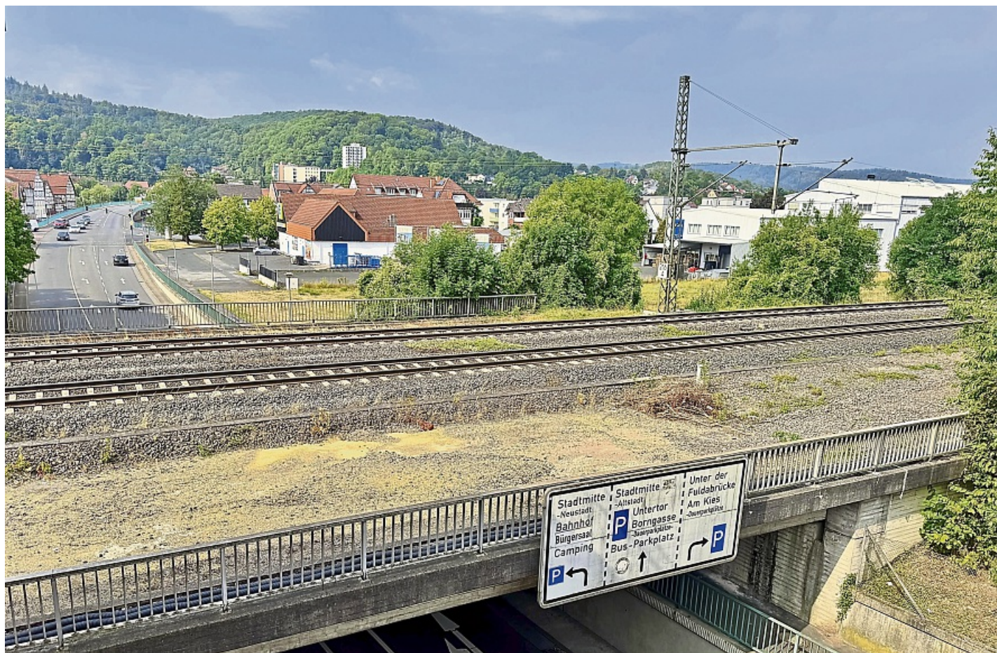
Die Eisenbahnüberführung am Rotenburg-Center soll 2027 durch einen Neubau ersetzt werden. Für den Einbau der neuen Brückenteile muss die Landesstraße voraussichtlich rund drei Wochen voll gesperrt werden. FOTO: CAROLIN EBERTH
