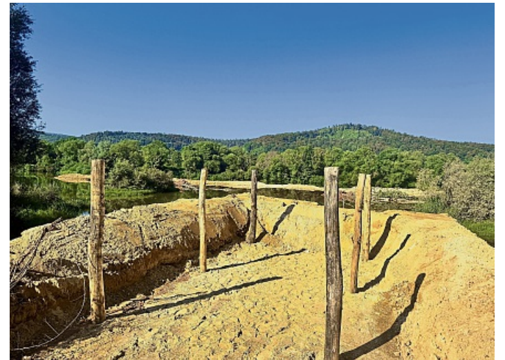
Hier entsteht ein überdachter Beobachtungsstand für Besucher. Von dort aus sollen künftig Tiere und Pflanzen am Braacher Kiessee beobachtet werden können.
