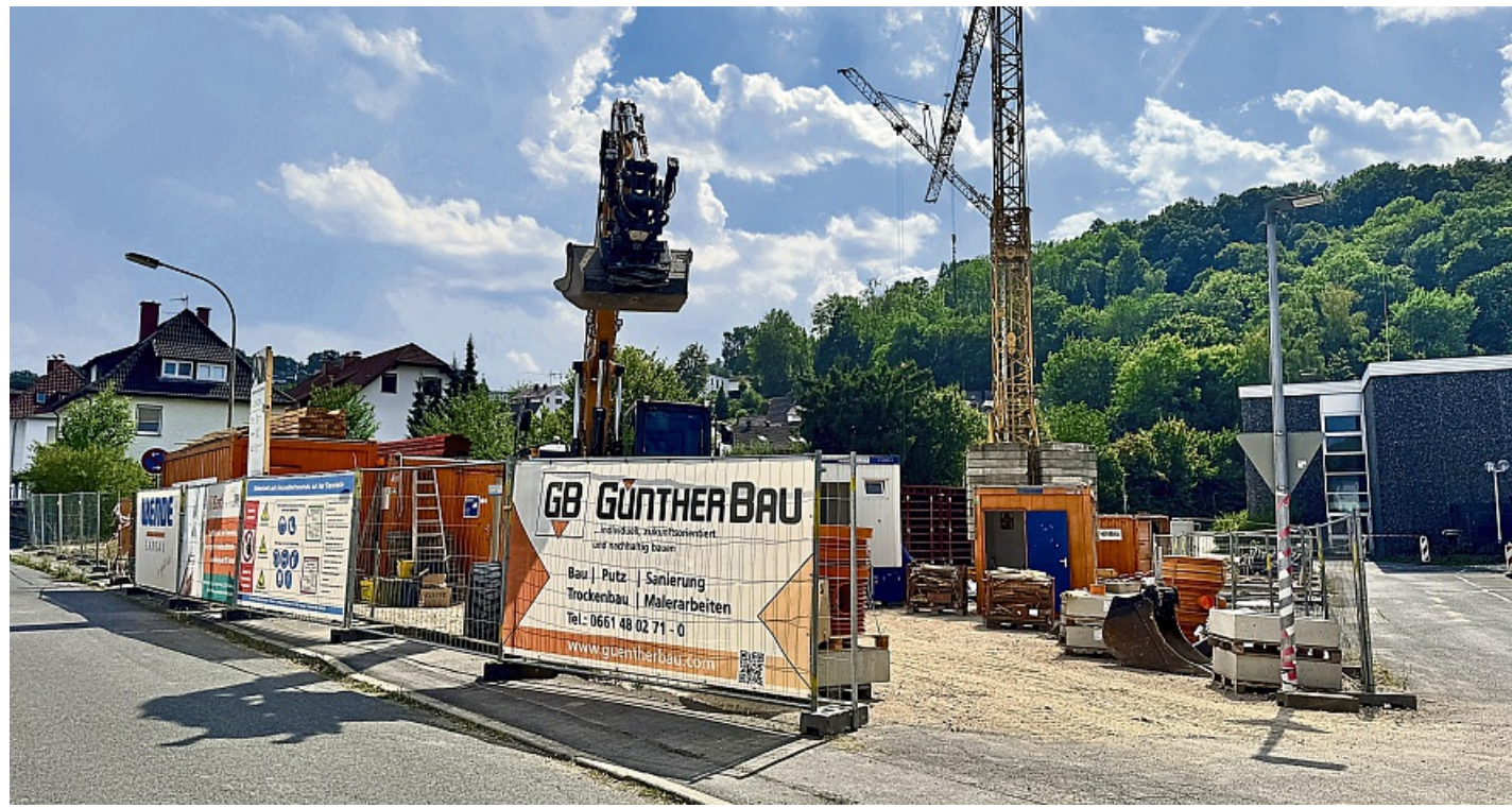
Der Neubau mit 120 Unterbringungsplätzen am Studienzentrum Rotenburg liegt nach Angaben des Landesbetriebs Bau und Immobilien Hessen weiterhin im Zeitplan. Die Fertigstellung ist für das erste Quartal 2027 vorgesehen.
