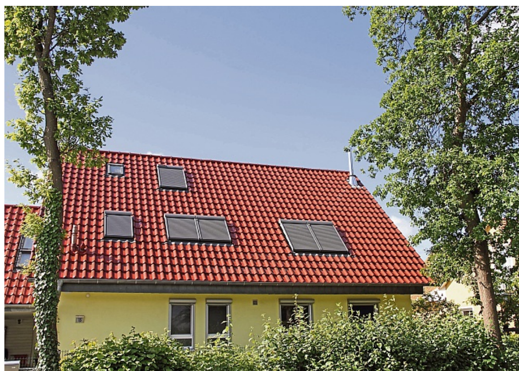
Ein gut gedämmtes Dach und außen liegender Sonnenschutz an den Dachfenstern sind der beste Schutz vor steigenden sommerlichen Spitzentemperaturen.
