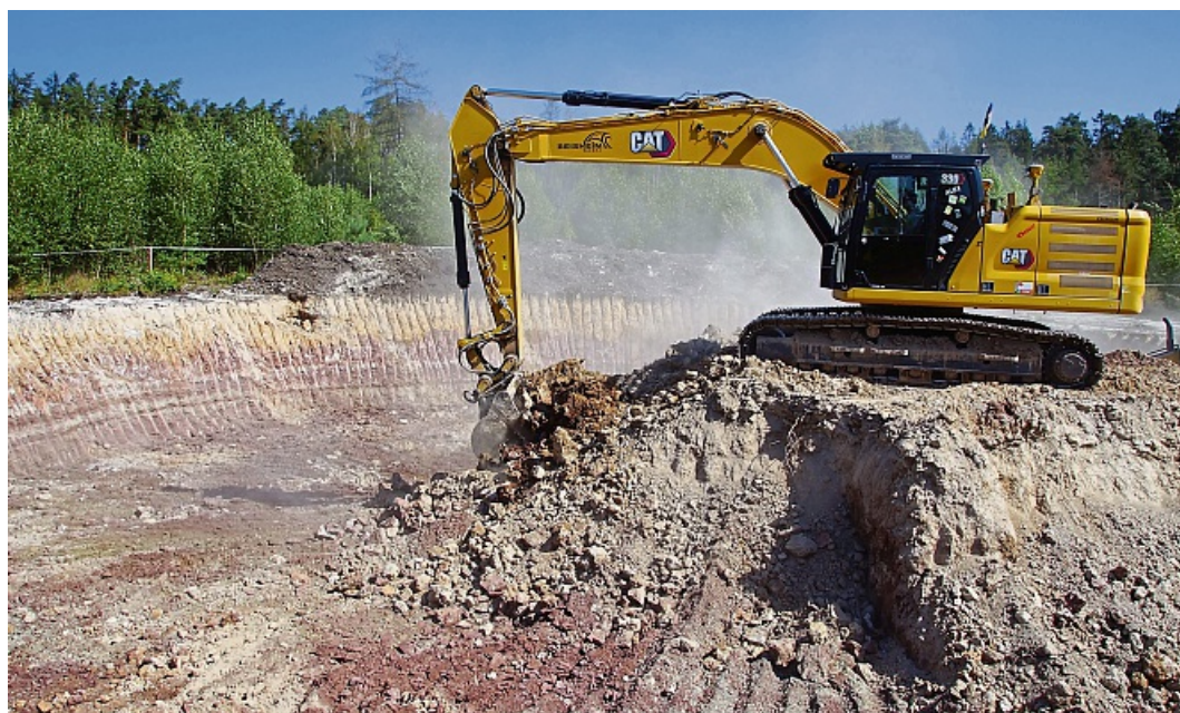
Schwere Maschinen im Einsatz: Mitarbeiter der Bebraer Baufirma Beisheim heben im Buchwald die Fundamente für die Windräder des Windparks Wippershainer Höhe aus.
