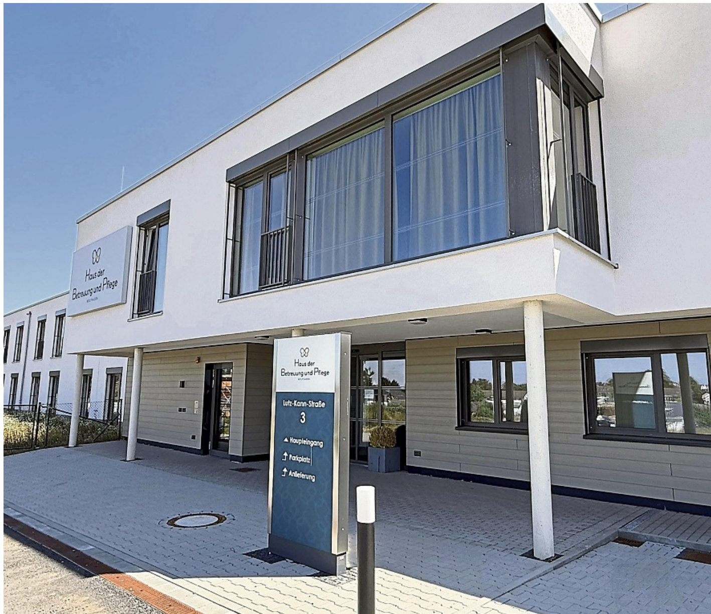
Die Wohnpflegeeinrichtung im Wolfhager Neubaugebiet soll jetzt erst im September eröffnet werden. Zuletzt sorgten Brandschutzmängel für Verzögerung.
