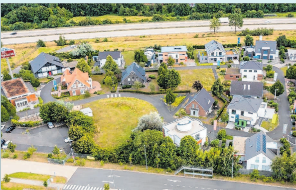
In einer von bundesweit sechs FertighausWelten lässt sich die Vielfalt und Qualität moderner Fertighäuser erleben.
