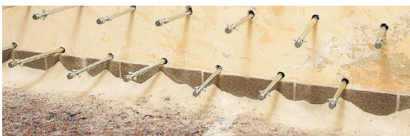
Kellerabdichtung durch Injektion
