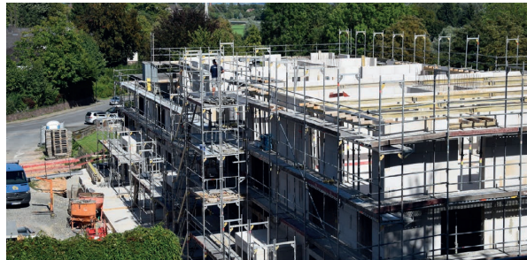
Der Rohbau des Projekts »Weitblick Höxter« hat Gestalt angenommen.
