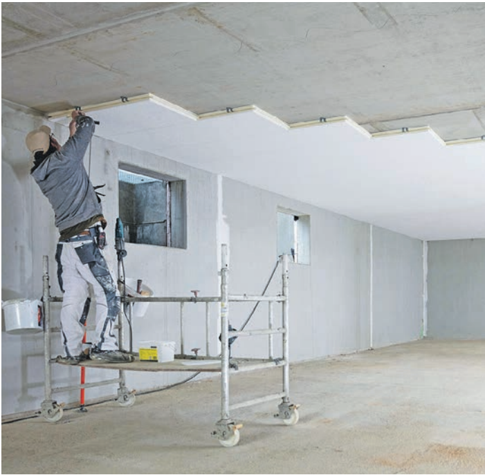
Für mehr Kopffreiheit sollten Bauherren, gerade im Bestand, auf eine hohe Dämmwirkung bei geringen Plattendicken achten. Foto: DJD/Linzmeier Bauelemente
