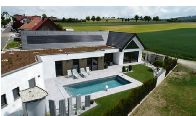
Elegante Lösung: Die nahezu unsichtbar in das Schieferdach integrierte Photovoltaik-Anlage versorgt den modernen Neubau mit Strom, treibt das E-Auto und die Wärmepumpe an – und sieht dabei auch noch gut aus. Schiefersteine gelten als eine der robustesten und nachhaltigsten Dacheindeckungen. Fotos: Rathscheck
