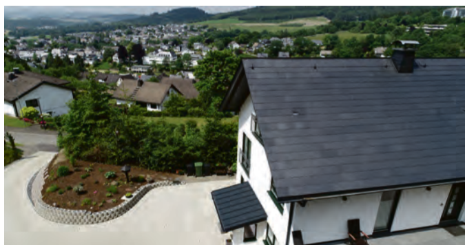
Schöne Aussichten: Um gemeinsam mit dem Sohn unter einem Dach zu wohnen, hat die Familie im Sauerland noch einmal neu gebaut – und dabei auf Nachhaltigkeit, Langlebigkeit und Folgekosten geachtet. Das moderne Schieferdach aus Rechtecksteinen kann jederzeit einfach um integrierbare Photovoltaik-Module ergänzt werden. Fotos: Rathscheck
