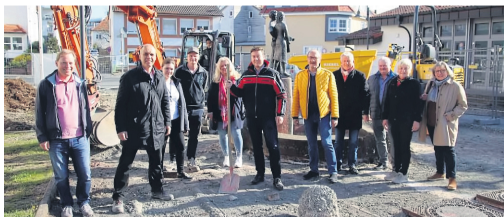
Bürgermeister Matthias Möller (Bildmitte) beim offiziellen ersten Spatenstich zusammen mit Vertretern aus Verwaltung, Kommunalpolitik und von ausführender Firma.
