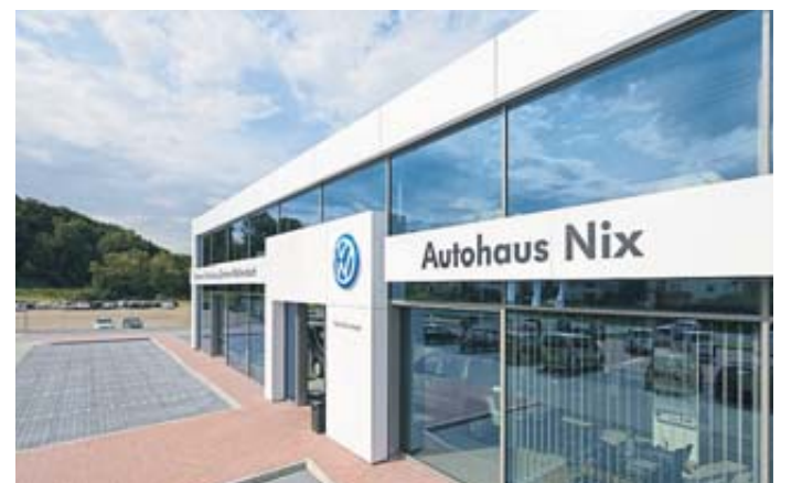
Für PKW und Nutzfahrzeuge von Volkswagen bietet das Familienunternehmen Nix einen Rundum-Service. Foto: Autohaus Nix
