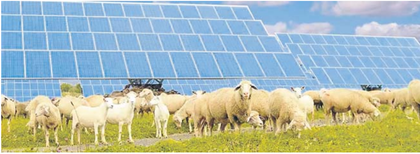
Schlüchtern will mit der Gründung der „Energie Bergwinkel GmbH“ eigene Wege bei der Erzeugung von Strom und Wärme gehen. Foto: Stadt Schlüchtern
