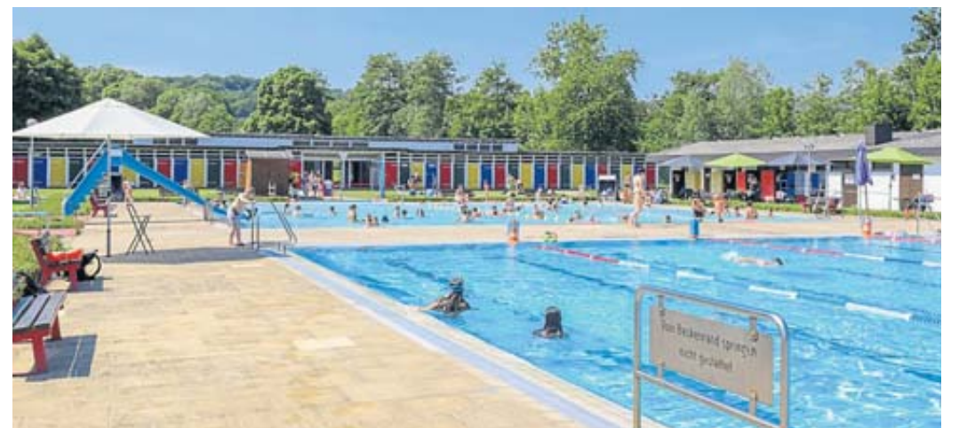
Die Stadt Schlüchtern setzt den symbolischen Spatenstich für den Schwimmbadumbau beim Familienfest am Dienstag, 3. Oktober. Archivfoto: Stadt Schlüchtern
