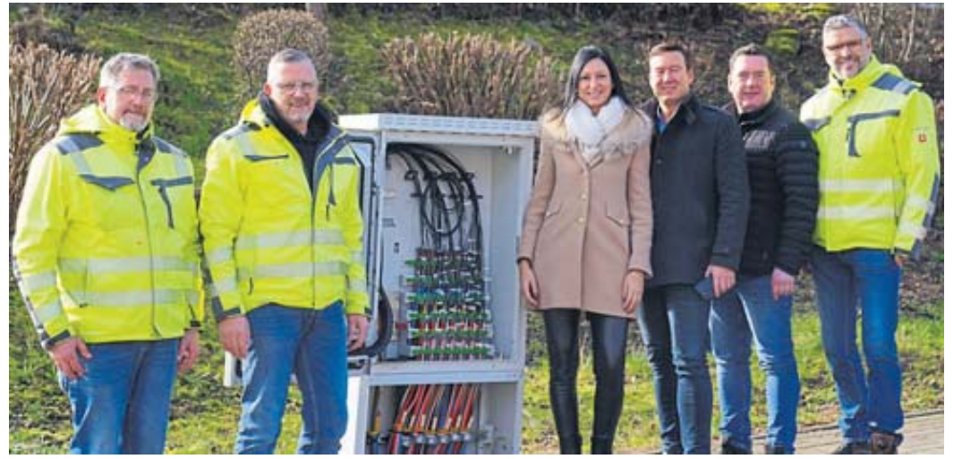
Sie arbeiten an einer nachhaltigen Lösung in Schlüchtern (von links): Markus Kohlhepp und Torsten Sawierucha von Kurt Leitungstiefbau, Breitband-Geschäftsführerin Simone Roth, Bürgermeister Matthias Möller, Marc Lotz vom Bauhof sowie Thomas Braun, Projektleiter Außenbereich bei Athanus Partners.. Foto: Bensing & Reith
