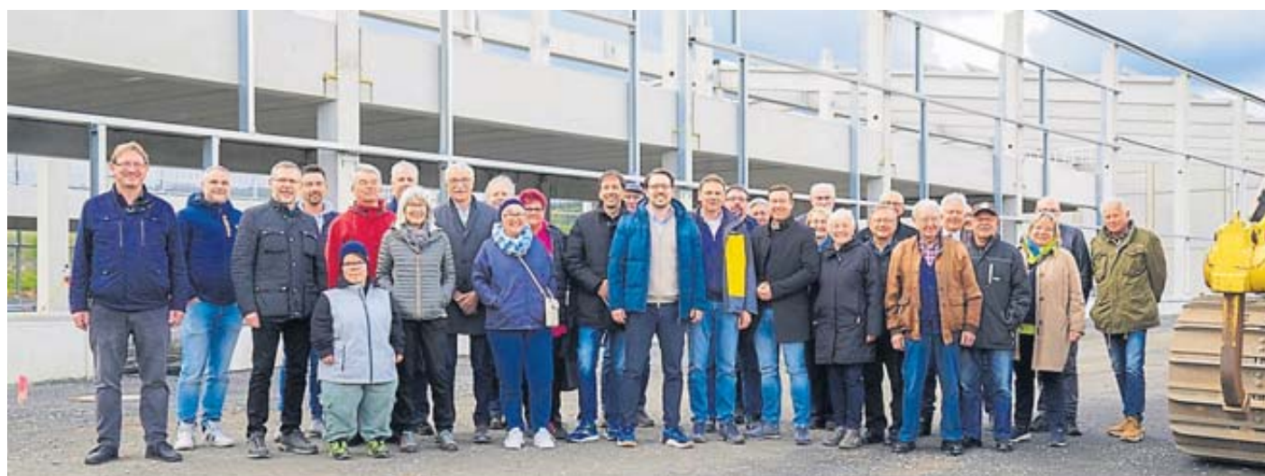
Das Interesse war riesig, als Vomberg-Prokurist Gerhard Wiegand (13. von links), Geschäftsführer Andreas Roßmar (Bildmitte, 15. von links) und Bauleiter Peter Ebner (16. von links) den sich im Bau befindlichen neuen Vomberg-Standort präsentieren. Fotos: Bensing & Reith
