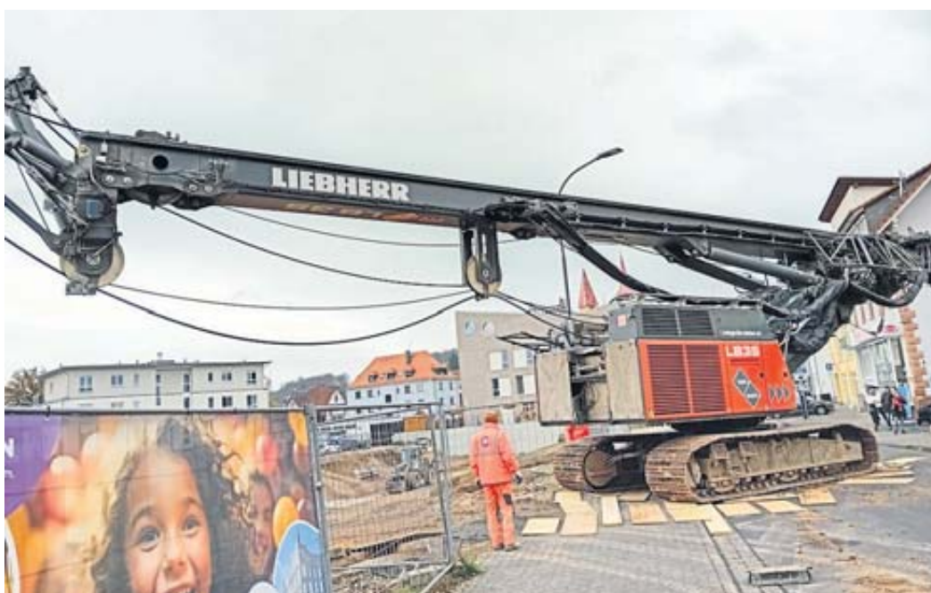
Mit einem Tieflader wurde das rund 100 Tonnen schwere Spezialbohrgerät in der Bahnhofstraße angeliefert. Foto: Stadt Schlüchtern
