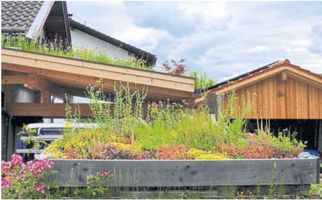
Die ganze Pracht eines Biodiversitätsdachs ist auf diesem Carport zu sehen. Foto: Ingrid Völker
