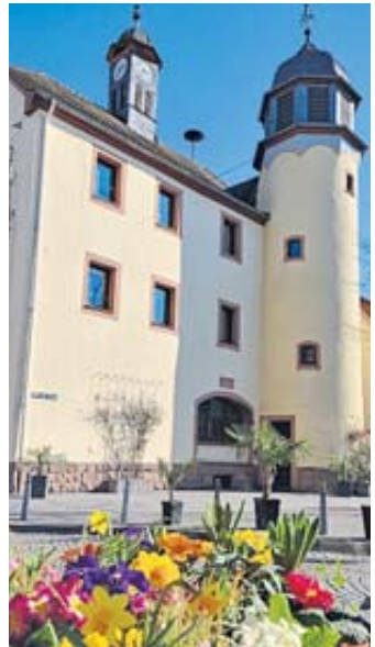
Das Rathaus Schlüchtern wurde im Stil der Renaissance an der alten Handelstraße von Frankfurt nach Leipzig errichtet. Archibild: privat
