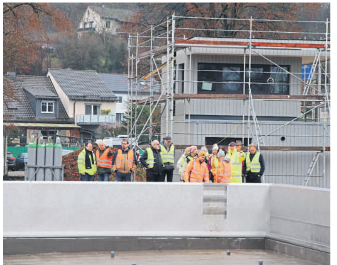
Die Erhöhungen der Becken sind mittlerweile installiert. Im Hintergrund der künftige Turm für den Bademeister. Fotos: Stadt Schlüchtern
