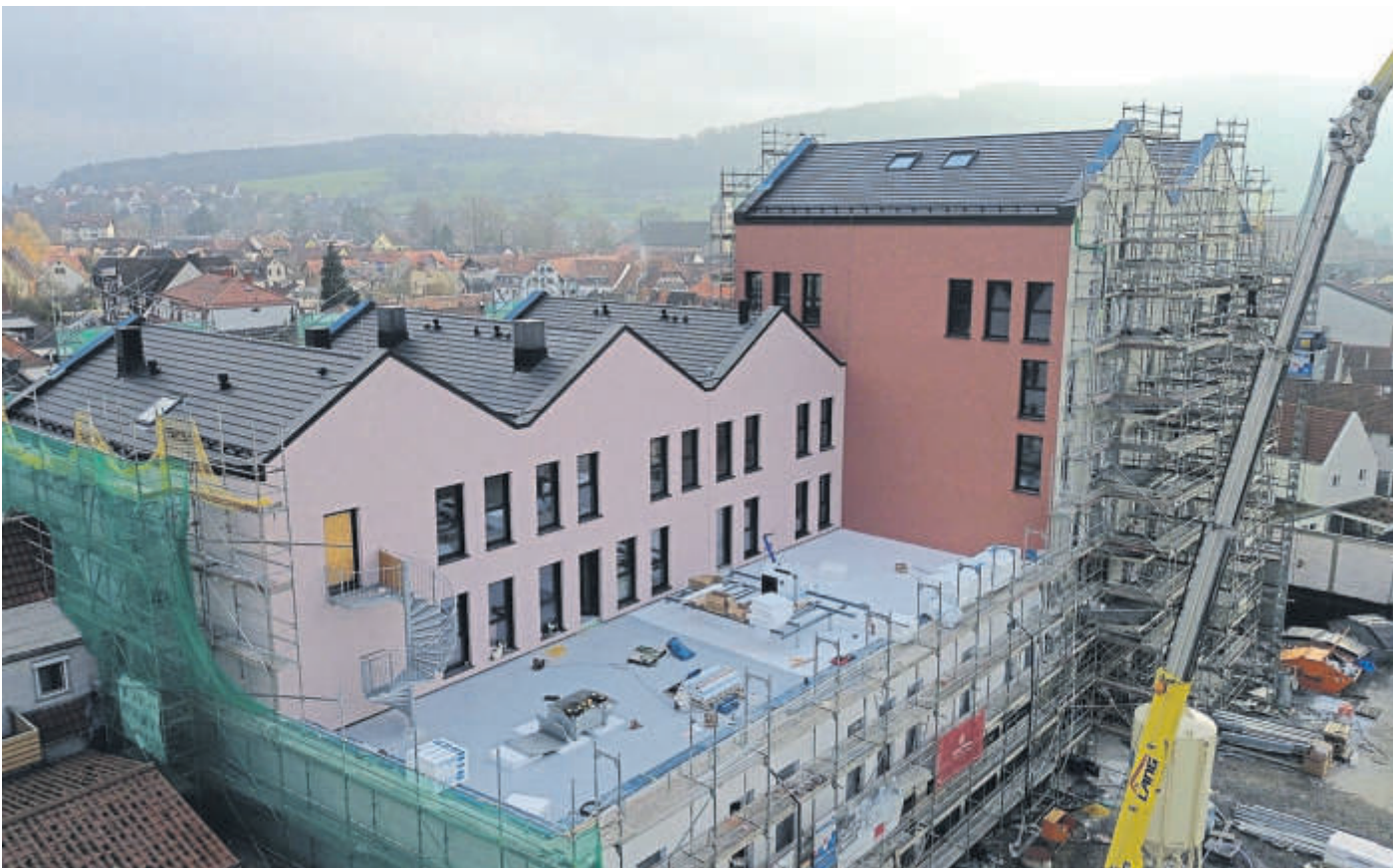
Auf dem ehemaligen Langer-Areal entsteht das Neue Obertor. Mittlerweile ist der Gebäudekomplex sogar schon teilweise verputzt. Fotos: Stadt Schlüchtern
