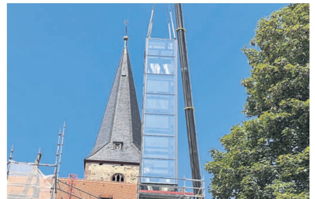
Das Kloster wird teilweise umgebaut und barrierefrei gemacht. Im August kam der Aufzug.
