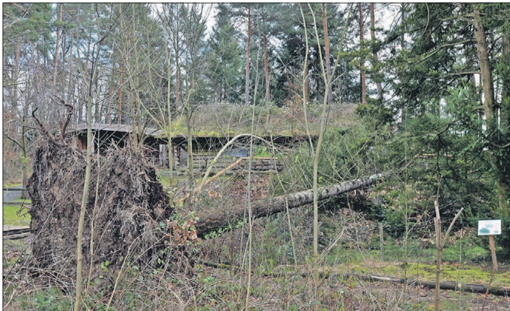
Im Schulwald am Altenhöfer Weg sind mehrere Bäume umgestürzt. Einer davon hat die „Förster-Jörg-Schultz-Hütte“ beschädigt.
